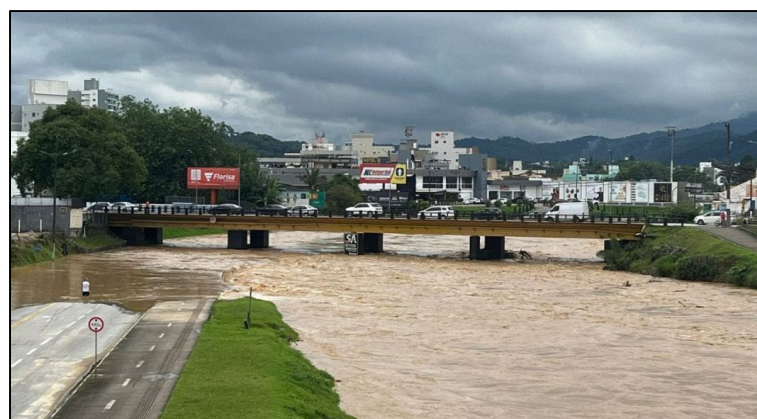
Figura 1 – Ponte durante cheia do rio
