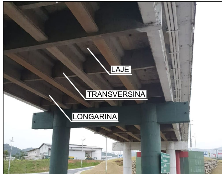
Figura 3 – Vista inferior da Ponte João Libério Benvenuto em Brusque-SC
